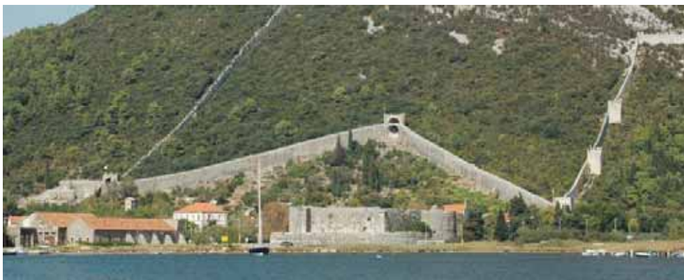
Ston von der Seeseite mit der Mauer
