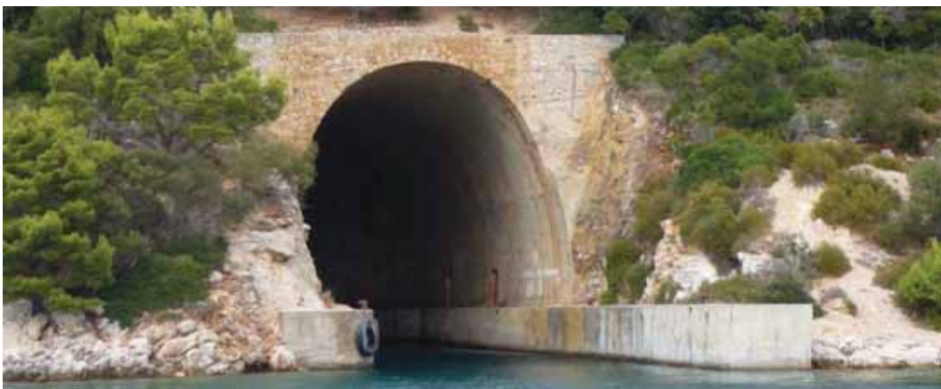
Liegeplatz-Erkundung am zweiten Bunker
